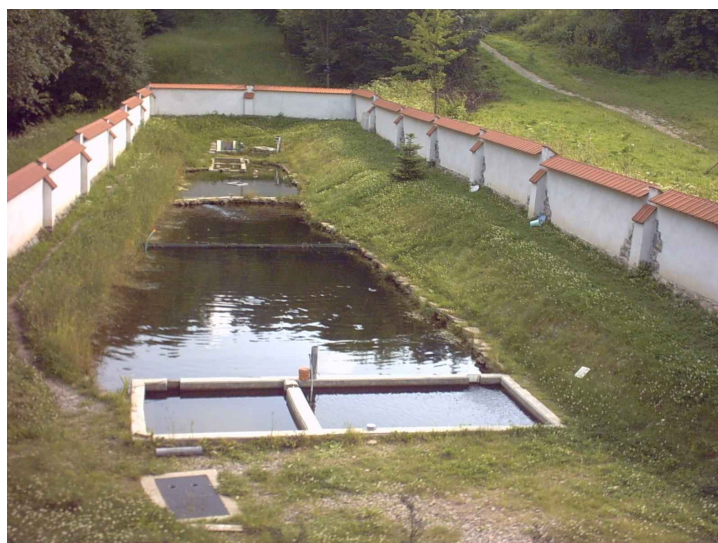
Inkubator, staw tarlakowy, staw manipulacyjny i płuczki obrębu hodowlanego w Myślenicach
